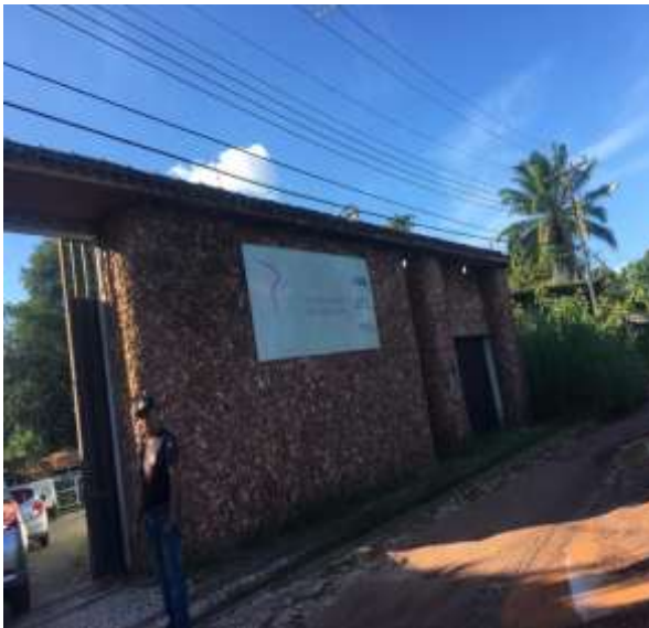
Entrada da Unidade Materno-Infantil de Ananindeua no Estado do Pará.
